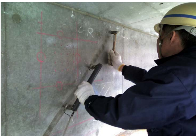
橋梁上部工桁側面の測定状況
